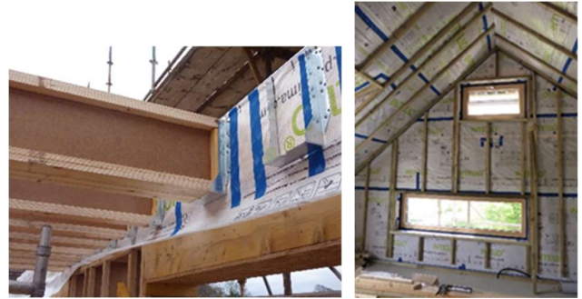
Fig 6. Vapour control layer
